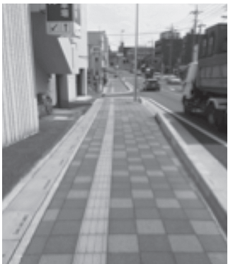
写真2 セミフラット形式の歩道の整備例
